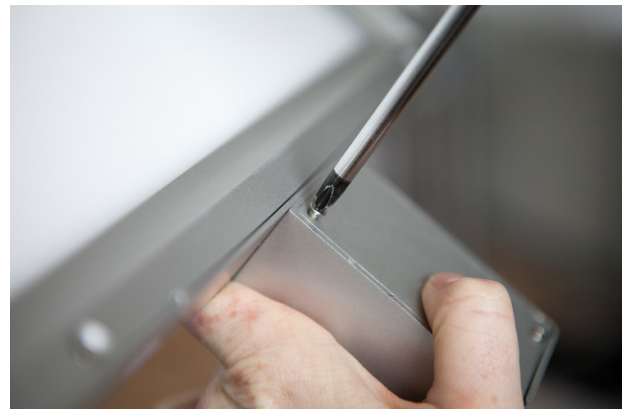
Abb.6: Anschrauben der Blende
